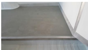
Protiskluzová podlaha s hliníkovými ochrannými lištami
