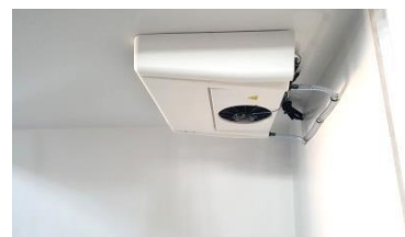
Detail stropu s integrovaným světlem a chladícím agregátem
